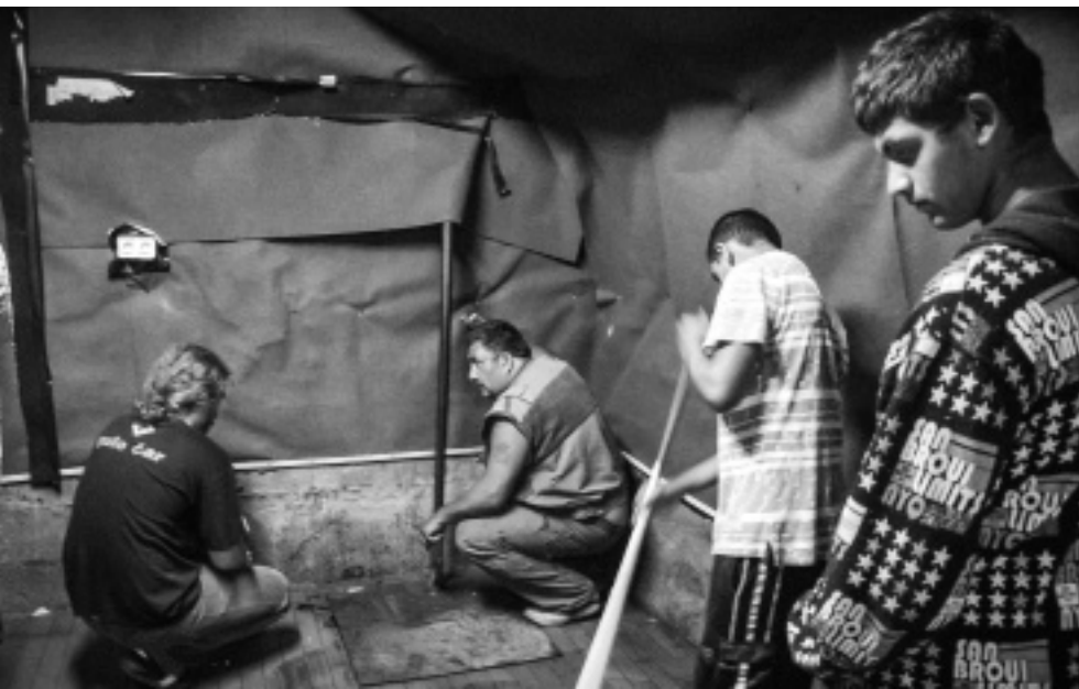
Obr. 16 – Odvodnění hudebny v komunitním centru Cheiron T v Táboře
